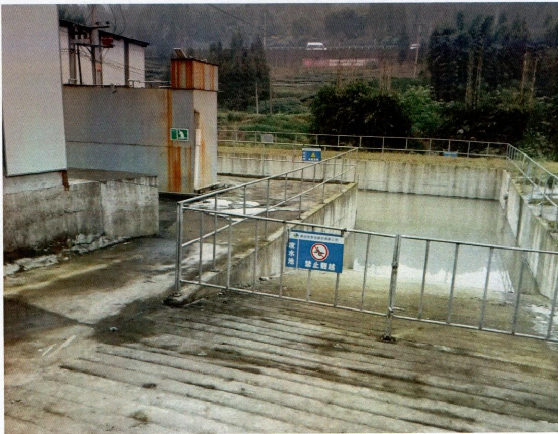
图 7：已完成并投入运行废水池
